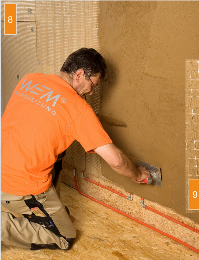
(8) Die gesamte Wandoberfläche wird mit zwei Lagen WEM® Lehmputz abspachtelt, ...
