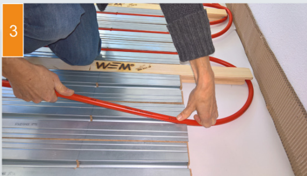
(3) Das Rohr wird in den Wärmeleitblechen verlegt und an den Heizkreisverteiler angeschlossen.
