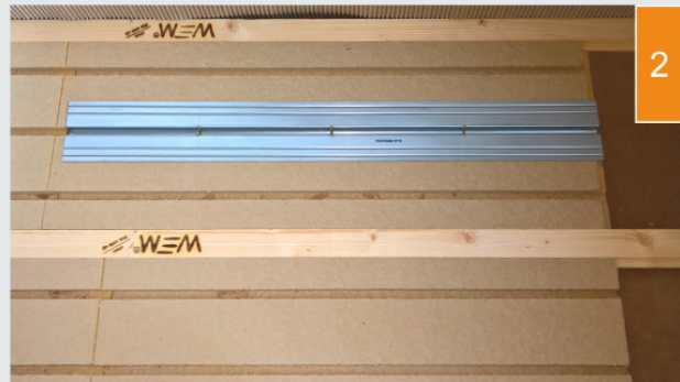
(2) Wärmeleitbleche werden in die Verlegeplatten eingelegt.
