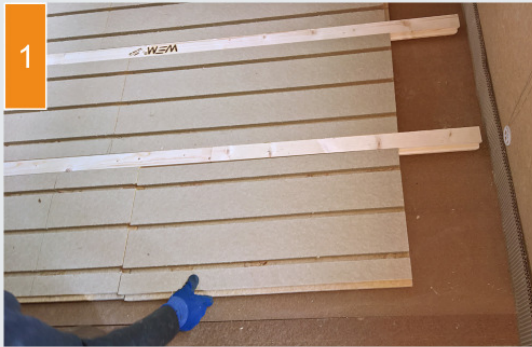
(1) Die Holzfaser-Verlegeplatten und Profilleisten werden ausgelegt.
