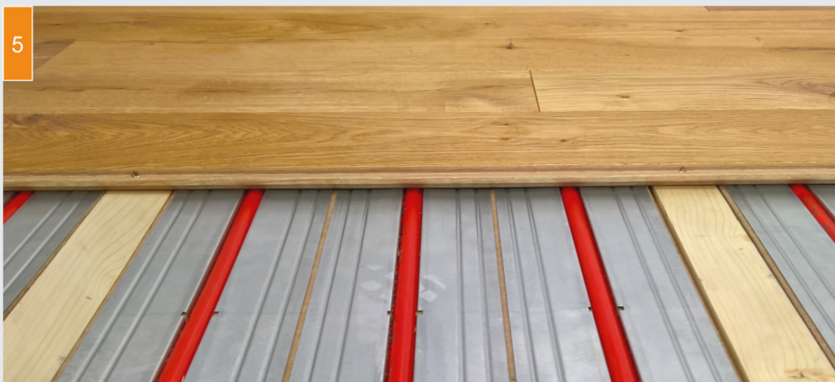
(5) Ein geeigneter Holzboden wird verlegt.
